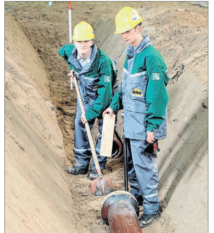
Auch Tiefbauarbeiten gehören zu den abwechslungsreichen Tätigkeiten auf der Baustelle. Fotos: zVg
